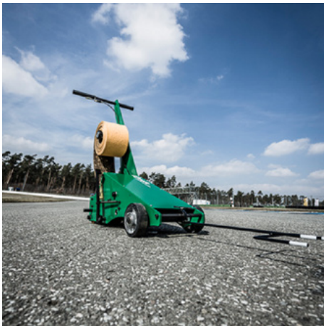
Tecnica di posa della bobina
