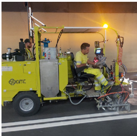
Машини для нанесення дорожньої розмітки
